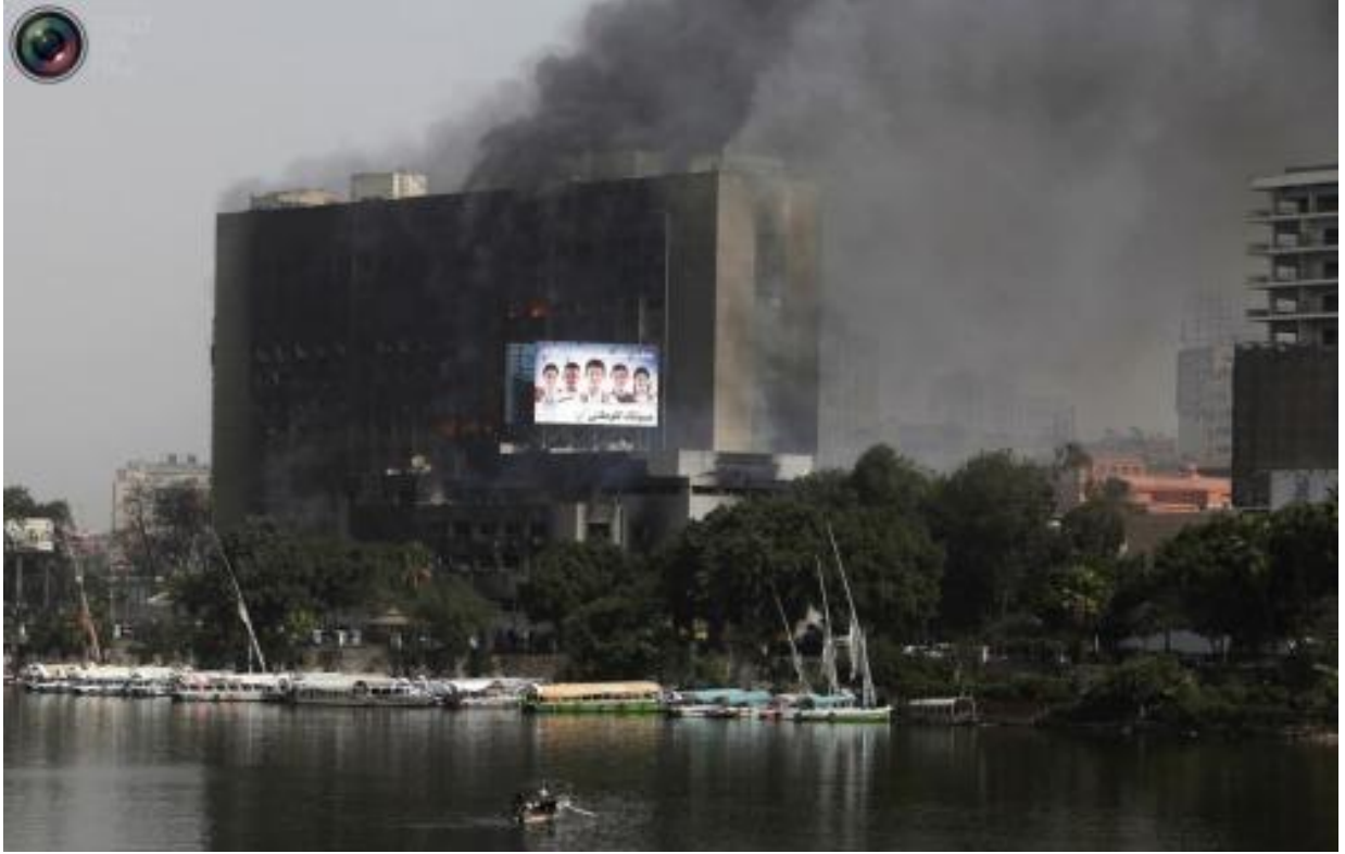
حرق مبنى الحزب الحاكم في القاهرة
